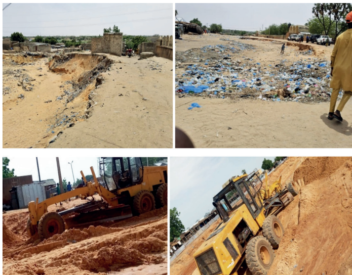
Quelques images des sites des travaux
