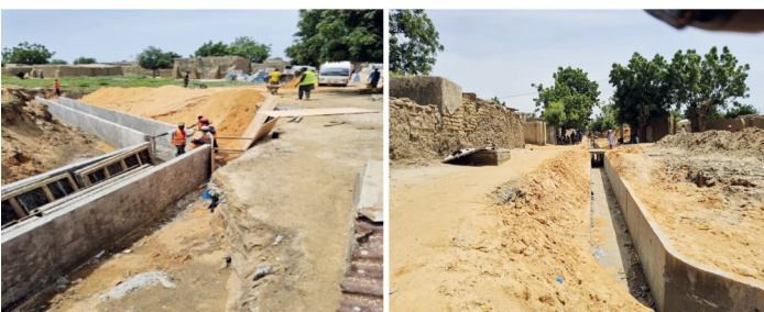
Quelques images des sites des travaux
