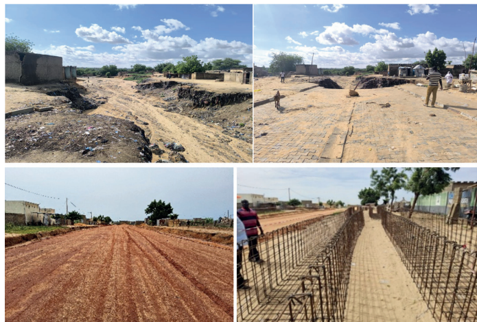
Quelques images des sites des travaux
