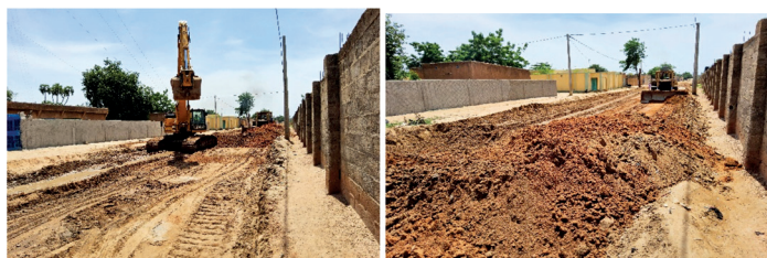
Quelques images des sites des travaux
