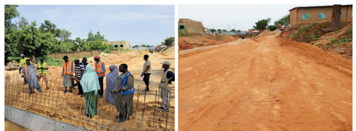
Quelques images des sites des travaux
